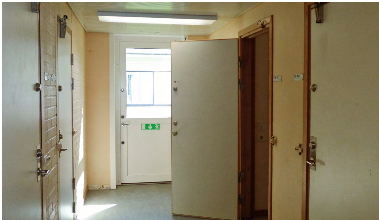
Cellkorridor i anstalten Brinkeberg
